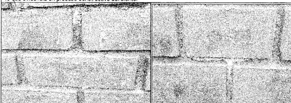
Se observa que la aplicación del barniz no se ha realizado correctamente, ya que se presentan áreas con desconchados y peladuras en la superficie de los ladrillos.
