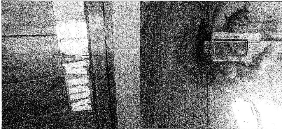
Se muestra el Aula 5 del Módulo 1, una separación de 3.9 mm lo que compromete su encaje y uniformidad superficial.
