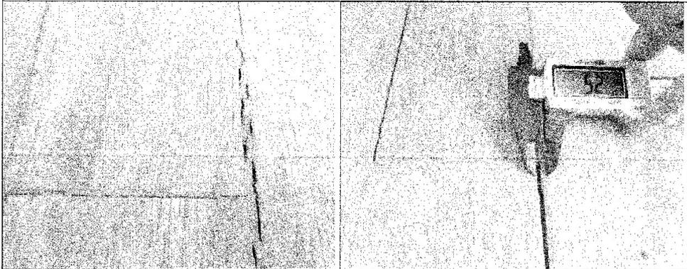
Se muestra el piso machihembrado con una separación considerable entre las tablas de 52 mm, debido a cambios de humedad y la instalación deficiente.
