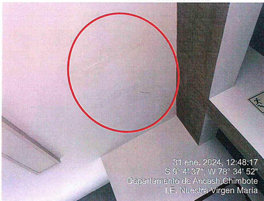
FISURAS EN LA LOSA DEL TECHO DEL PASADIZO CON PRESENCIA DE HUMEDAD
