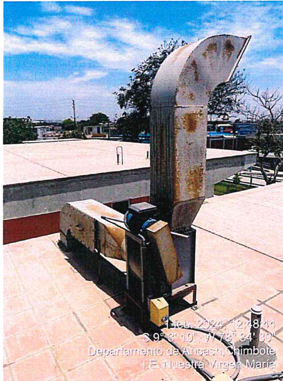
IMAGEN N° 8 MOTOR DEL EQUIPAMIENTO DE EXTRACCIÓN DE AIRE SIN PROTECCIÓN Y ÓXIDO EN DUCTOS
