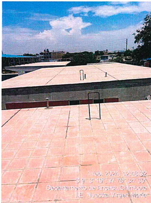
IMAGEN N° 11 PRESENCIA DE GANCHOS DE ACERO CORRUGADO INCRUSTADOS EN LA LOSA DE TECHO
