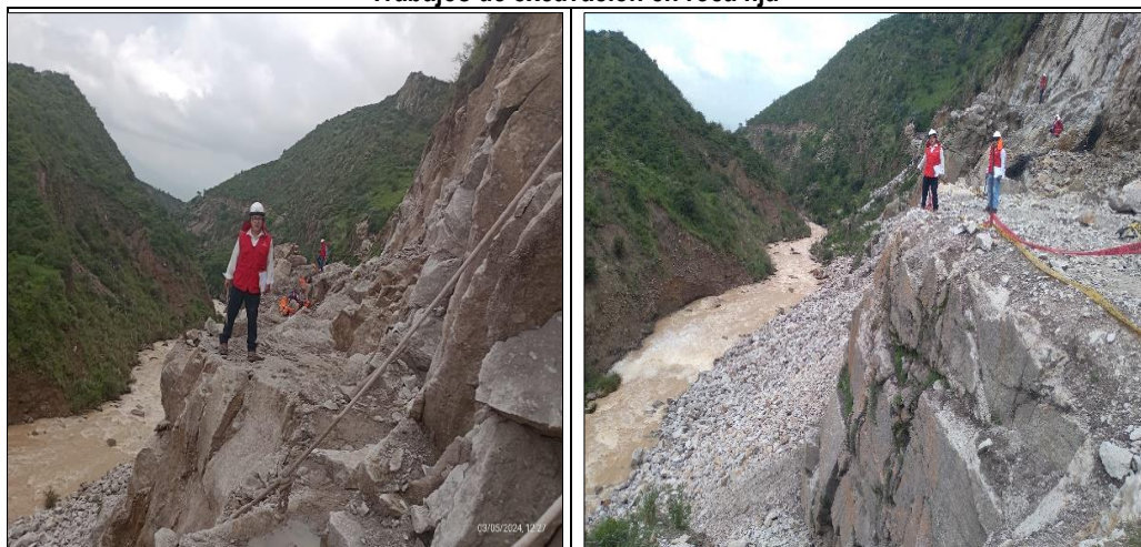
Imagen n.º 2 Trabajos de excavación en roca fija
