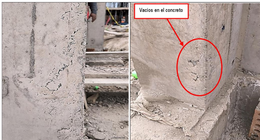
Segregación en elementos verticales - Bloque E5
