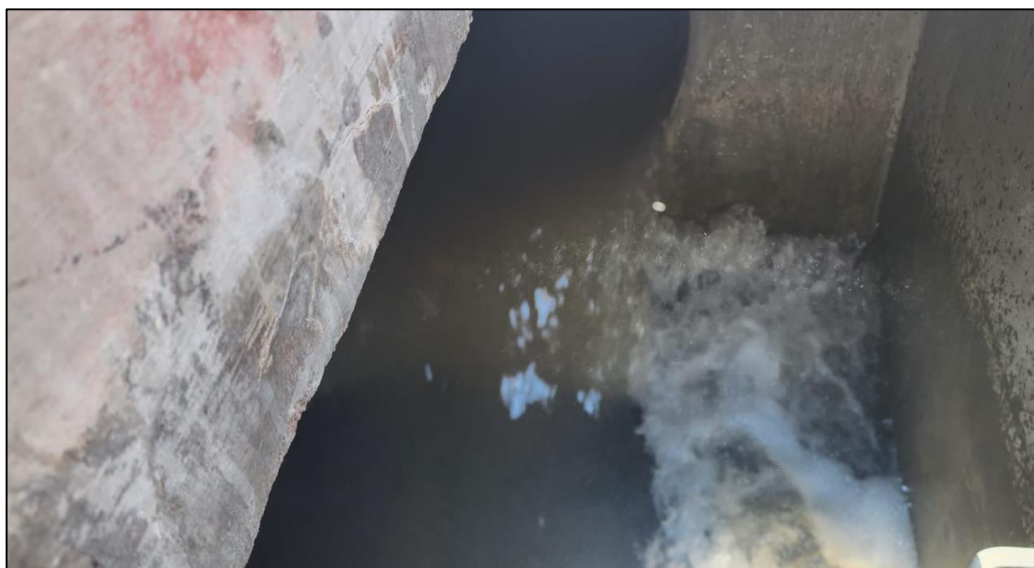
Fotografía n.º 3: En la cámara ubicada en la progresiva Km 2+605.94, se verificó que el tirante de agua ocupaba la cuarta parte del diámetro de la tubería que ingresaba a la misma.
