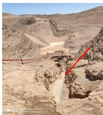
Vista del punto de rotura de la tubería Progresiva 17+668.54 Km rotura de la tubería por impacto
