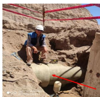
Vista panorámica de la válvula de purga 03, No existe dado de apoyo ni el suelo se ha mejorado Las propiedades mecánicas del suelo
