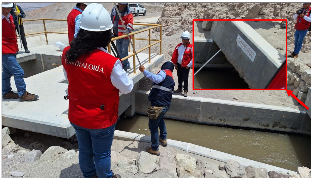
Fotografía n.º 2: Derivación de caudal antes del ingreso al desarenador de la línea de conducción n.º 1, hacia el canal de derivación al sector Jaguay – progresiva KM 0+010.600.
