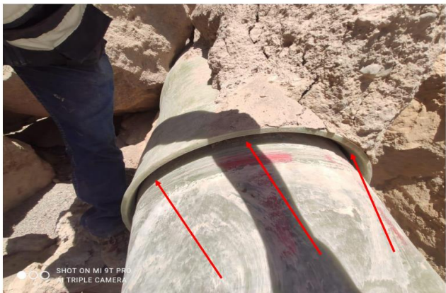
Vista panorámica de la tubería elongado en la junta de embone sin dado de anclaje que no cumple especificaciones técnicas del propuesto en el expediente técnico
