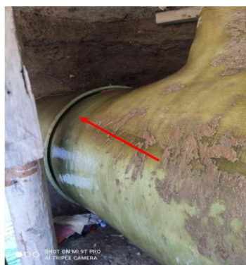
Vista Panorámica de la elongación Tubería GRP de D= 600mm
