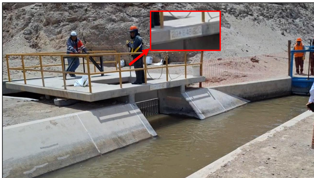
Fotografía n.º 1: Derivación en la progresiva KM 29+848.820 del canal Pasto Grande, en el que se verificó el ingreso de una parte del supuesto caudal de 650 litros por segundo hacia el canal de derivación del sector Jaguay.
