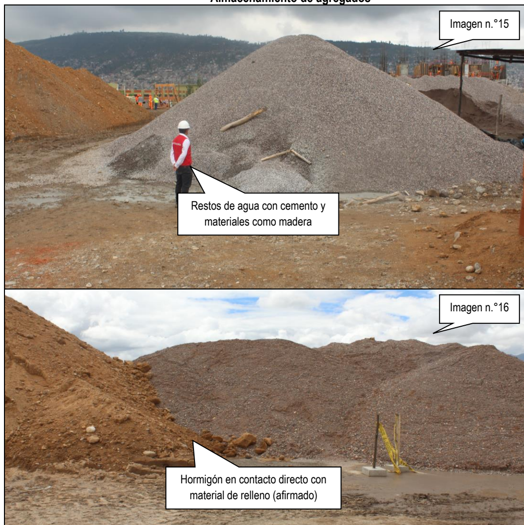
Imágenes n.ºs 15, 16 y 17 Almacenamiento de agregados
