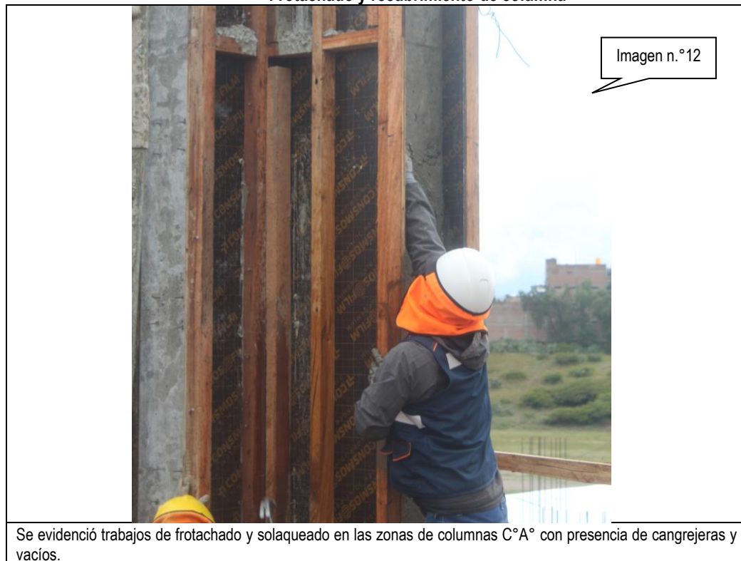
Imagen n.º 12 Frotachado y recubrimiento de columna
