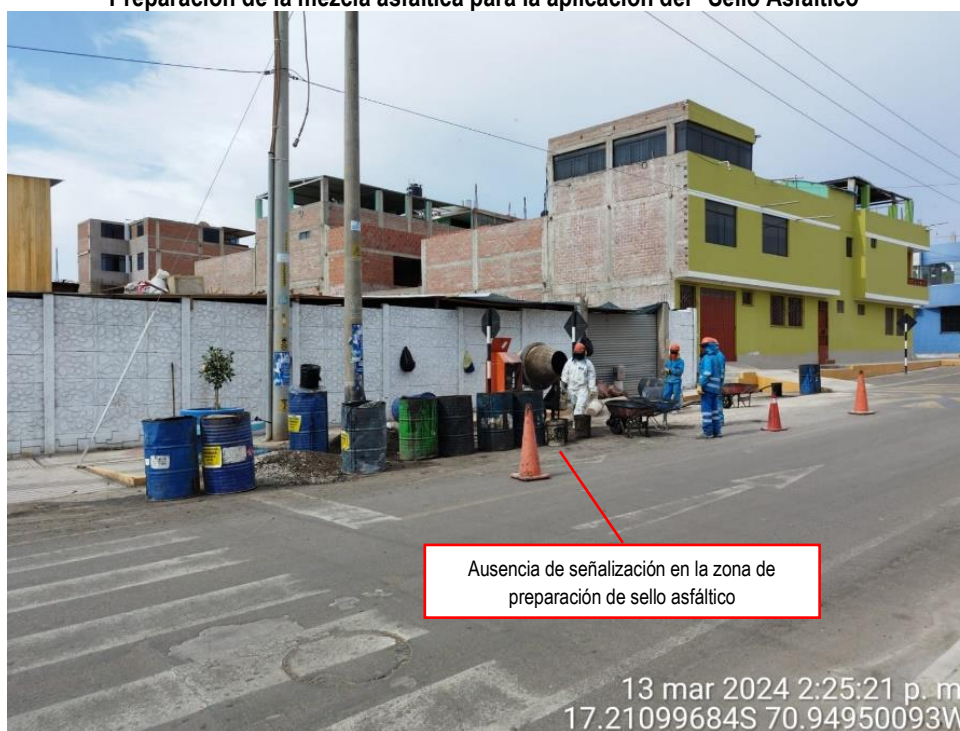
Imagen n.° 4 Preparación de la mezcla asfáltica para la aplicación del “Sello Asfáltico”
