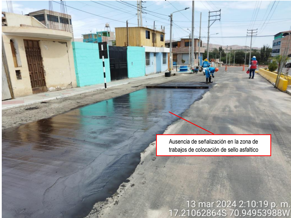
Imagen n.º 5 Aplicación de mezcla asfáltica de la partida "Sello Asfáltico"
