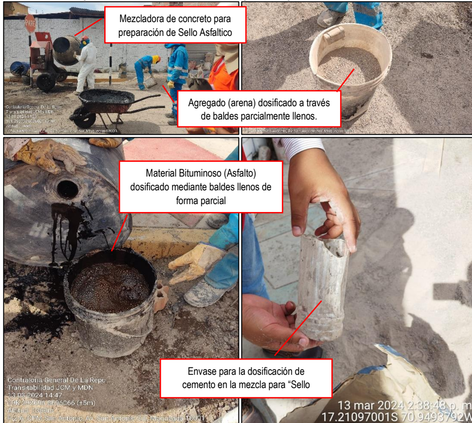
Imagen n.º 2 Preparación de la mezcla asfáltica para la aplicación del "Sello Asfáltico"
