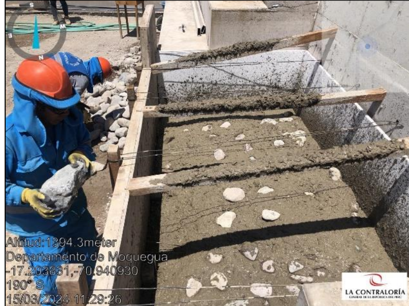
Imagen n.º 6 Vaciado de graderías concreto ciclópeo de f'c=175 kg/cm 2
