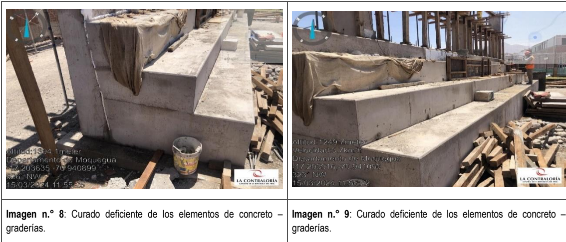
Imagen n.º 8 y 9 Proceso de curado de concreto
