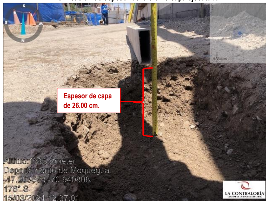
Imagen n.º 10 Verificación de espesor de la última capa ejecutada
