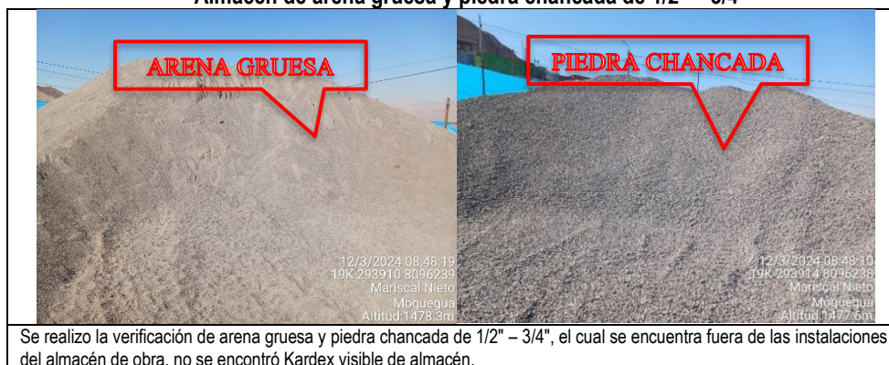
Imagen n.º 27 Almacén de arena gruesa y piedra chancada de 1/2" – 3/4"
