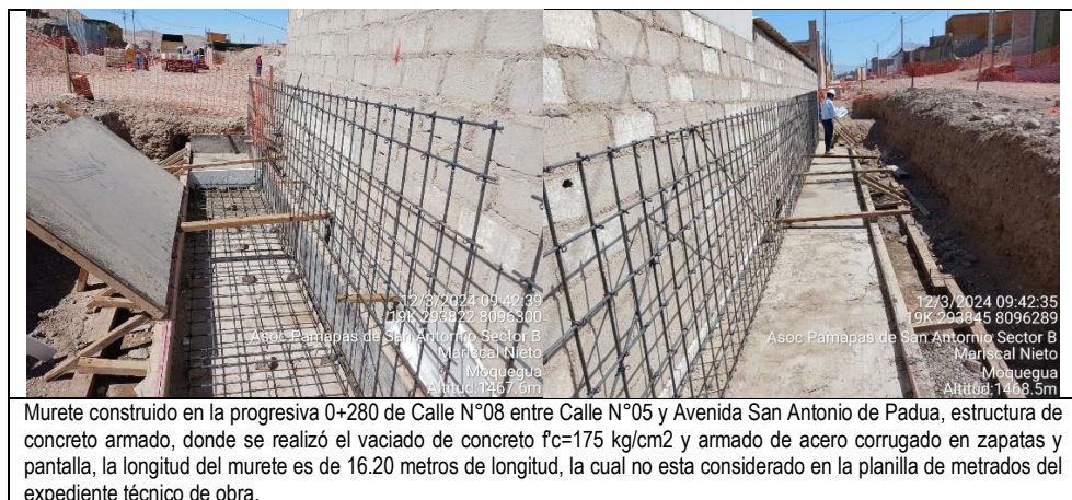
Imagen n. ° 14 Trabajos de vaciado de concreto f_c=175 \text{ kg/cm}^2 en zapatas y armado de acero corrugado en zapatas y pantallas
