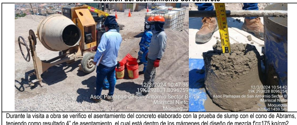
Imagen n.º 2 Medición del asentamiento del concreto
