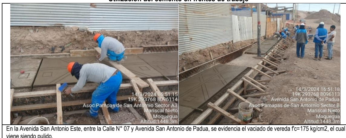
Imagen n.º 11 Utilización del cemento en frentes de trabajo
