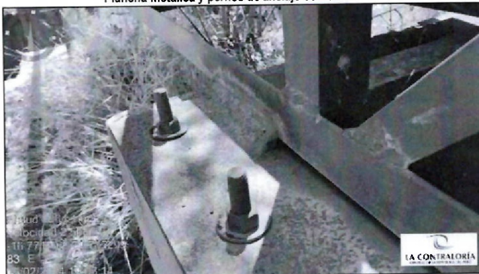
Imagen n.º 12 Plancha metálica y pernos de anclaje con óxido
