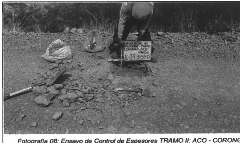
Fotografía 08: Ensayo de Control de Espesores TRAMO II: ACO - CORONG
