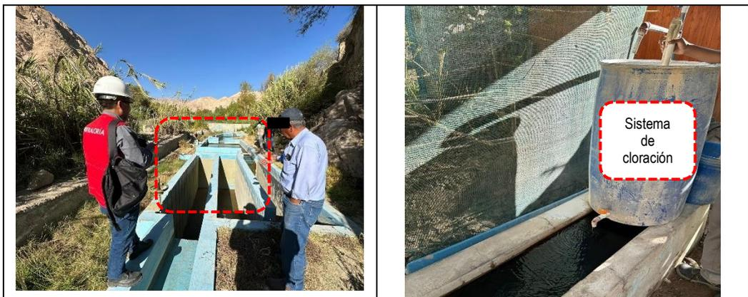
En relación al sistema de tratamiento de agua en el sector de Yunguyo, las vistas revelan la ausencia de medidas de control colectivo como brandas, etc.; asimismo, la ausencia de señales de seguridad relacionadas con el correcto almacenamiento, operación y manipulación del sistema de cloración provisional.
