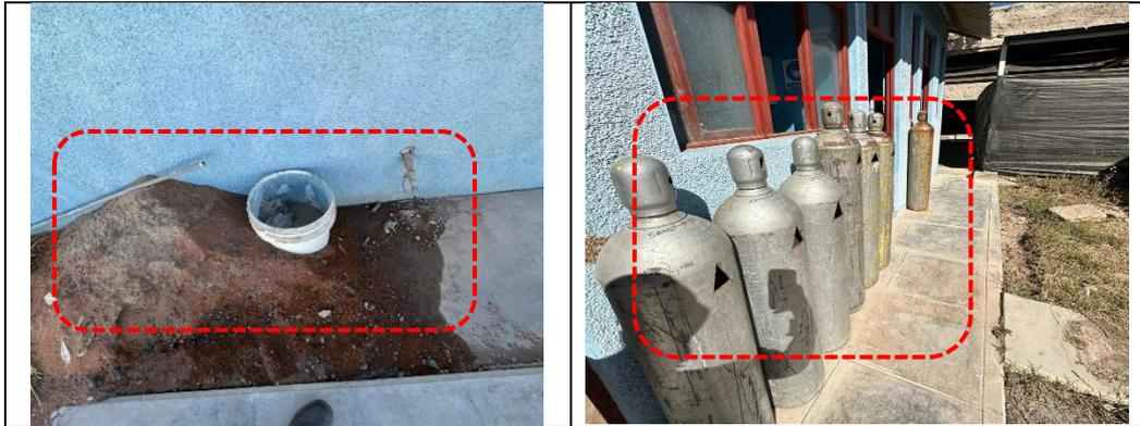
En el sistema de tratamiento de agua denominada "Comité 12", se observa el inadecuado almacenamiento de balones de cloro gas en desuso a la interperie sin señalización ni mecanismos que puedan evitar la caída a mismo nivel de los mismos; así como, la presencia de material del lecho filtrante a la interperie, sin señalización.
