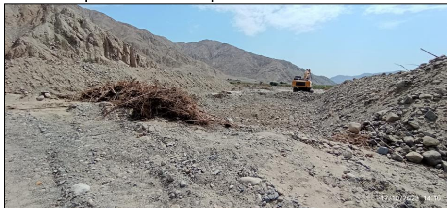
Imagen n.º 4 Inspección Física de Campo - Sector Santa Rosa 1
