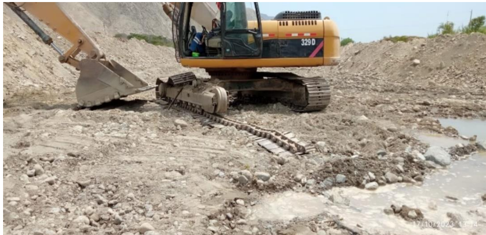
Imagen n.º 7 Excavadora descompuesta - Sector Santa Rosa 2
