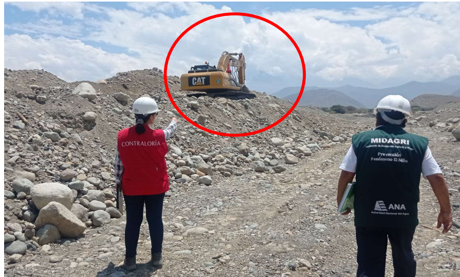
IMAGEN N°22: EXCAVADORA CAT 329 D SOBRE ORUGAS OBSERVADA DURANTE LA VISITA DE CAMPO
