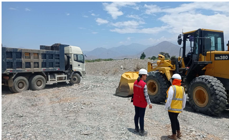
IMAGEN N°23: EXCAVADORA FRONTAL KOMATSU WA 380 SOBRE LLANTAS
