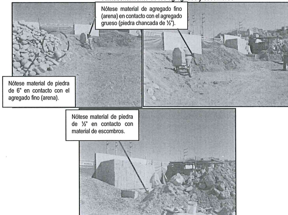
Imágenes N.º 3, 4 y 5 Almacenamiento de los agregados y escombros
