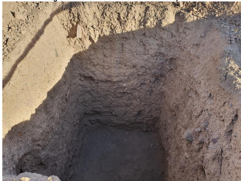
Imagen n.º 02 Fotografía de excavación de cimentación suspendida
