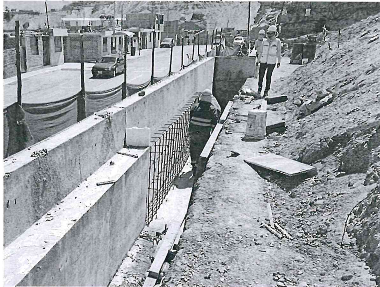
Imagen n.º 02 Cimientos corridos ejecutados frente a la Av. San Antonio Este y preparación de acero de refuerzo para concreto armado
