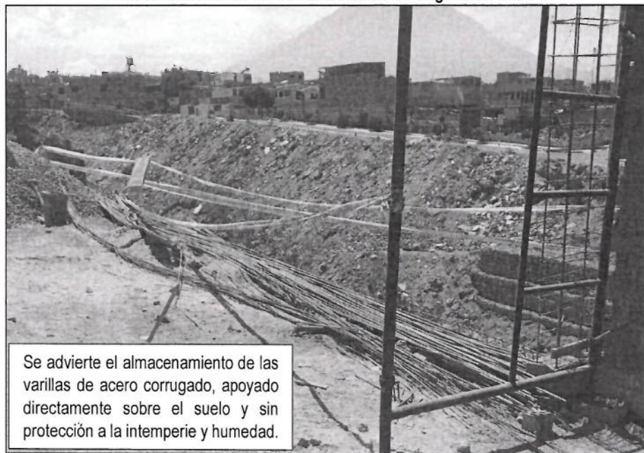
Imagen n.º 5 Almacenamiento de las barras de acero corrugado en la Obra
