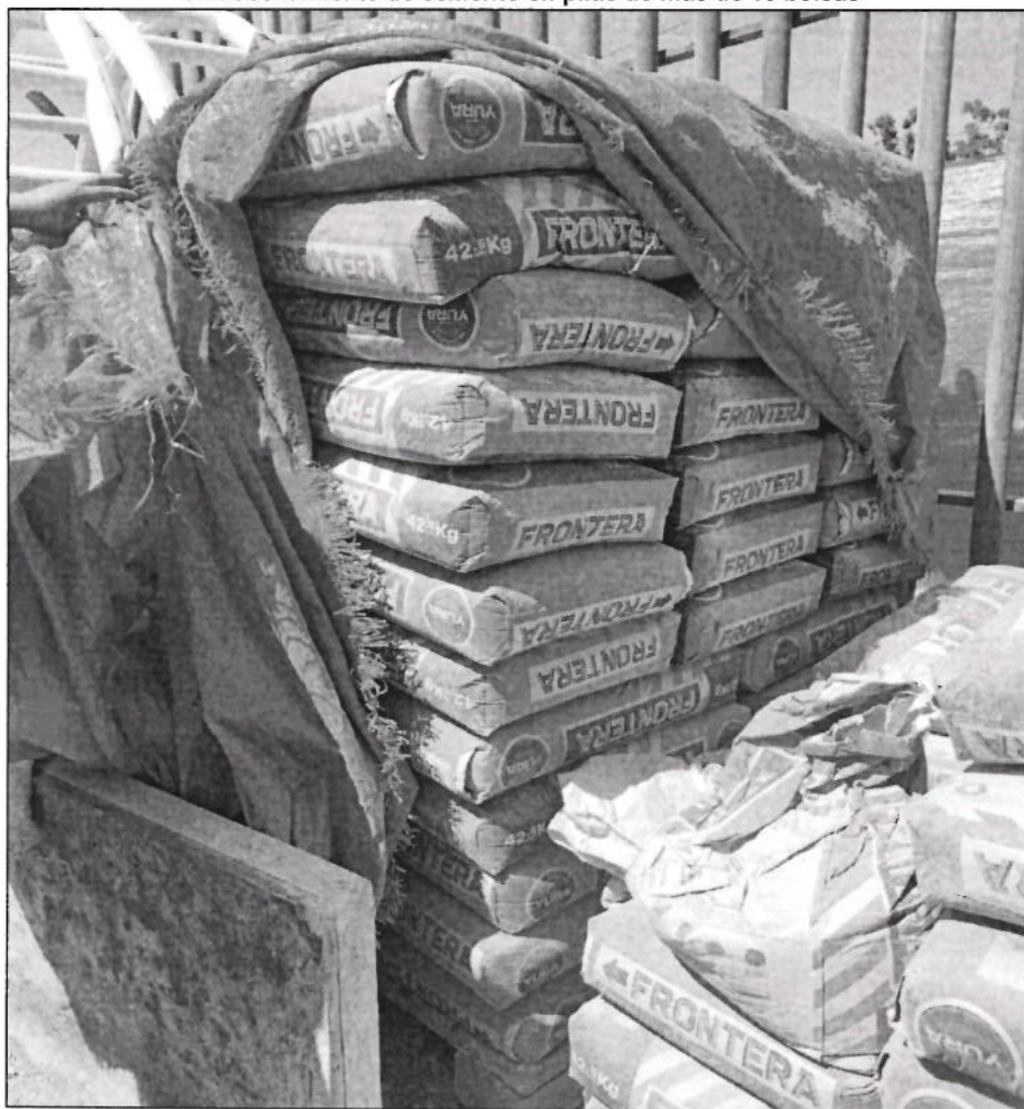
Imagen n.º 9 Almacenamiento de cemento en pilas de más de 10 bolsas
