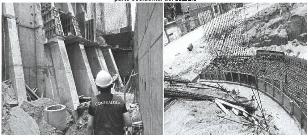
Fotografías n.º 7 y 8 Avances del adicional de obra, consistente en la construcción de muros de contención en la parte occidental del estadio
