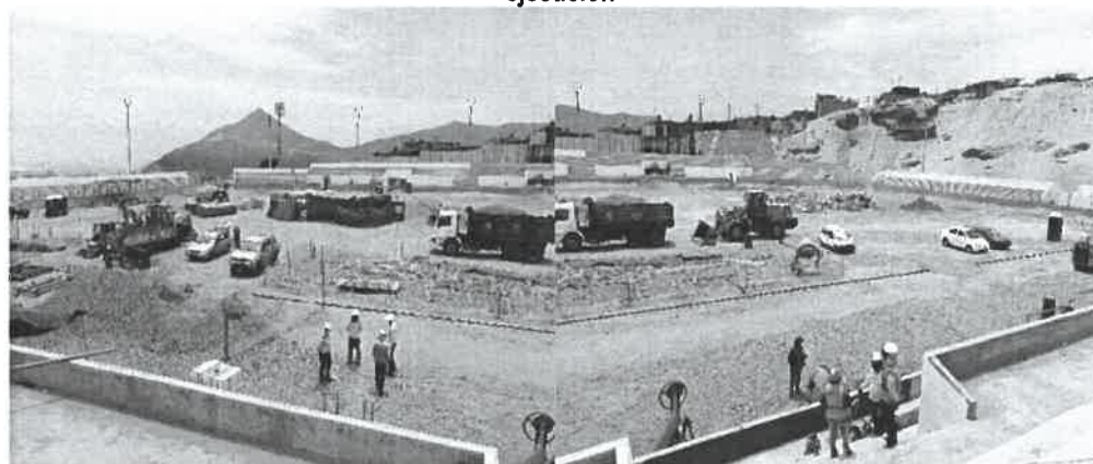
Fotografía n.º 3 Vista del avance del componente de Campo deportivo, nótese un reducido avance en su ejecución
