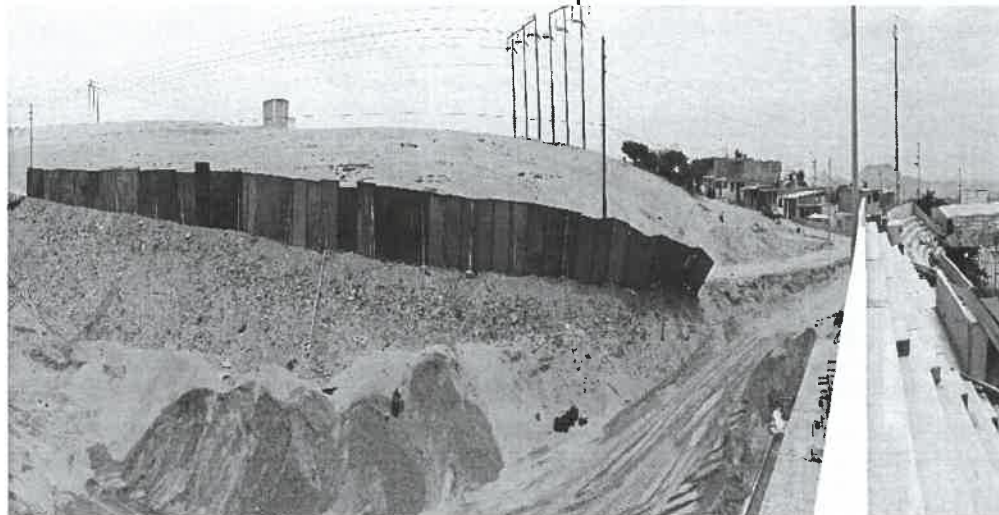
Fotografía n.º 6 Vista de la zona de la explanada sur
