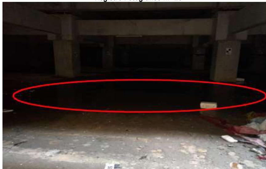
Agua empozada en sótano técnico del Bloque B.
