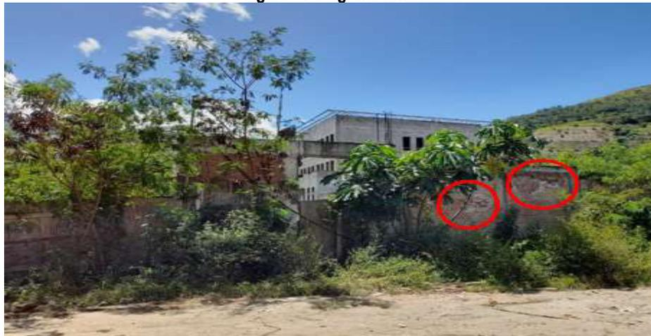
Presencia de eflorescencia en muro de ladrillo de cerco perimétrico en el Jr. General Gamarra.
