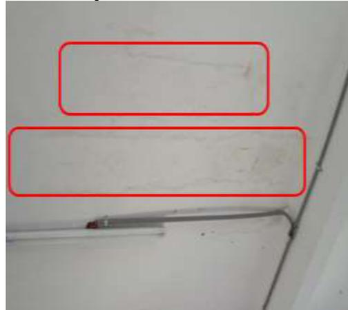
Marcas de filtración de agua en techo de Bloque H.
