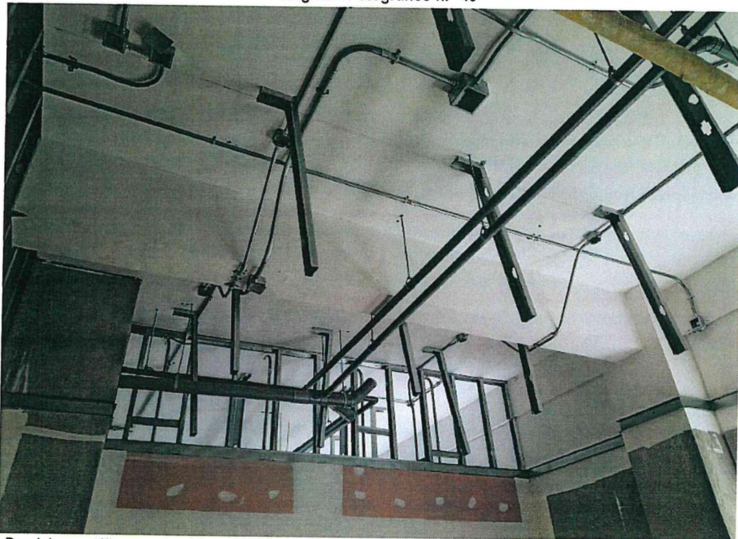
Bandejas metálicas portacables para el sistema eléctrico y de comunicaciones en un área de un pabellón del Hospital de Quillabamba.
