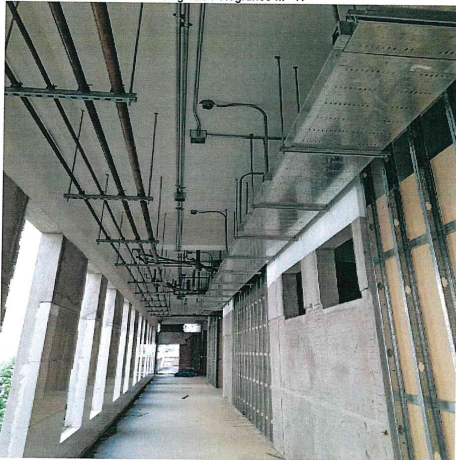
Bandejas metálicas portacables para el sistema eléctrico en uno de los pasadizos de un pabellón del Hospital de Quillabamba.
