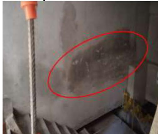
Presencia de eflorescencia en escalera de sótano técnico del Bloque B.
