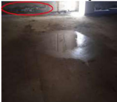
Presencia de eflorescencia en sótano técnico del Bloque B.
