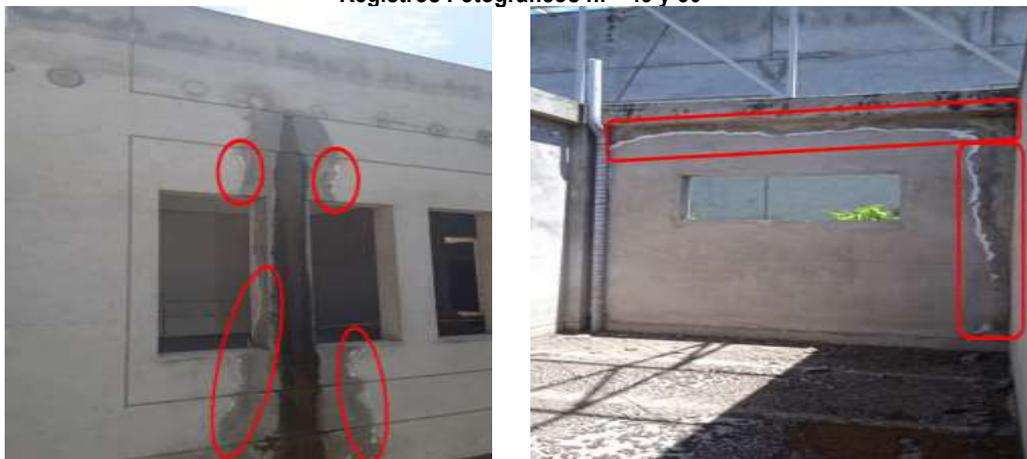
Presencia de humedad y eflorescencia en muro del cuarto al segundo piso del Bloque B.
