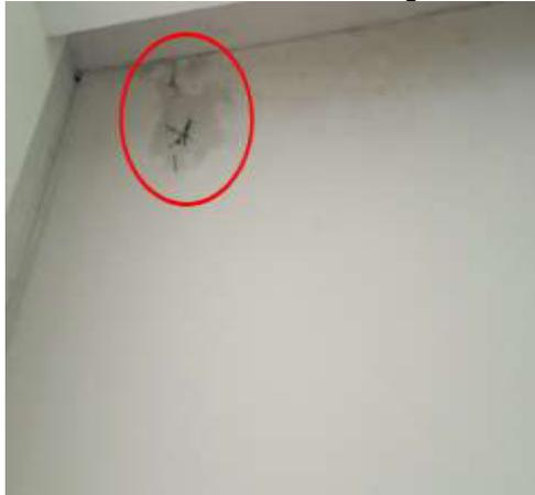
Filtración de humedad en techo de Bloque H.
