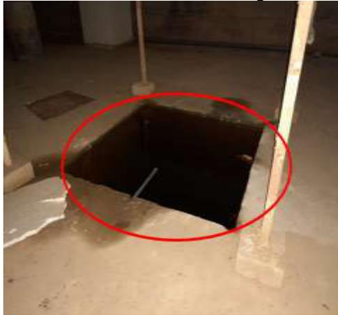
Agua almacenada en pozo sumidero 02 del sótano técnico del Boque B.
