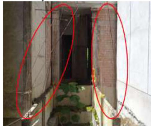
Presencia de óxido en acero de refuerzo de pozo de concreto frente al Bloque C.
