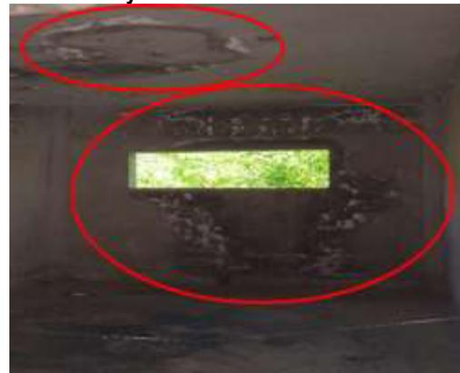
Presencia de eflorescencia en techo y pared del Bloque J.
