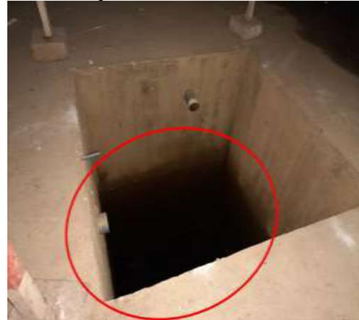
Agua almacenada en pozo sumidero 03 del sótano técnico del Boque B
