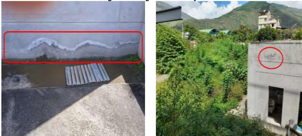
Presencia de eflorescencia en techo del primer piso del Bloque B.
