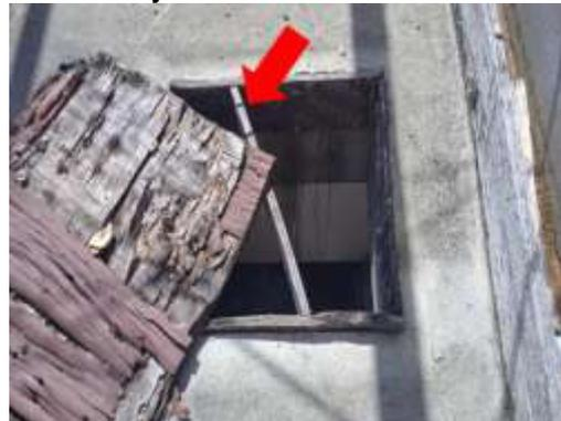
Ducto de techo en Bloque B, con tapa de madera reseca.
