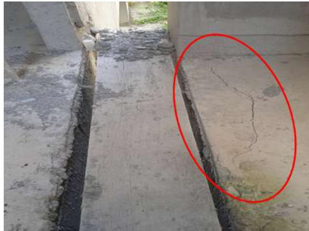
Borde fisurado en junta de separación entre el Bloque A y el Bloque B.
