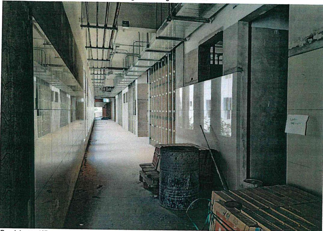
Bandejas metálicas portacables para el sistema eléctrico y de comunicaciones en uno de los pasadizos de un pabellón del Hospital de Quillabamba.
