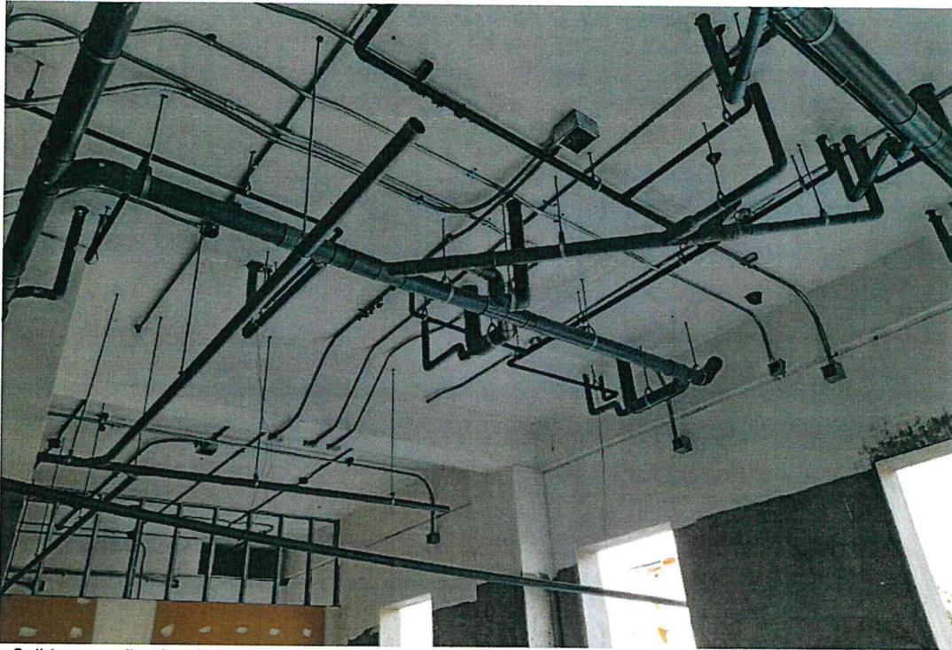
Salidas para iluminación, colgadores con tuberías de PVC y tubería Conduit adosada al techo en uno de los ambientes de un pabellón del Hospital.
