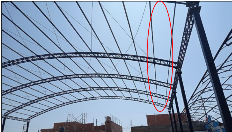
FOTOGRAFIA N° 4 COBERTURA DEL COMPLEJO DEPORTIVO EN EJECUCIÓN
