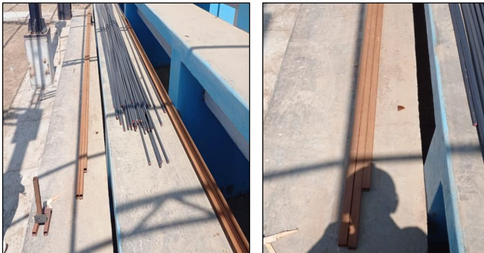
FOTOGRAFIAS N OS 2 Y 3 FIERROS DE CONSTRUCCIÓN EXPUESTO A LA INTEMPERIE
