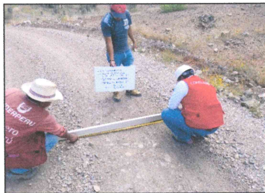
FOTOGRAFÍA N° 9 MEDICIÓN DE PARTÍCULAS DE AFIRMADO (KILOMETROS 5+000 - 6+000)
