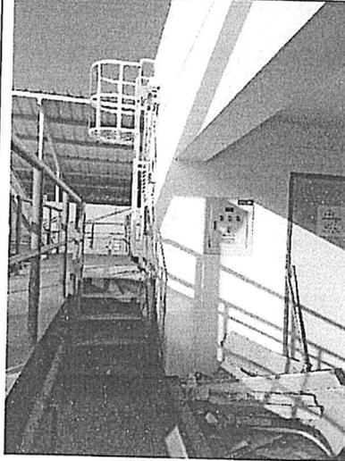
Imagen n.º 11: Verificación de los accesos a los techos y coberturas en el BLOQUE A1 y A2.
