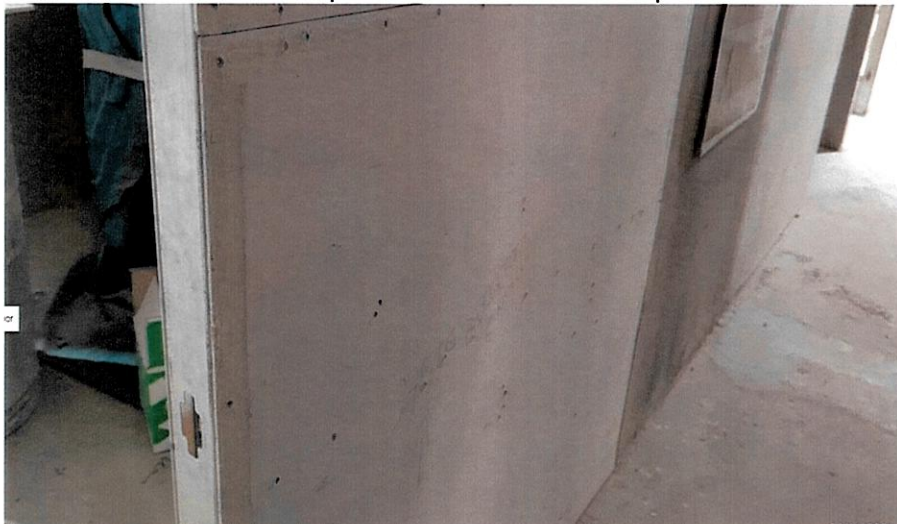
Toma Fotográfica n.º 8 Plancha de superboard con orificios en su superficie
