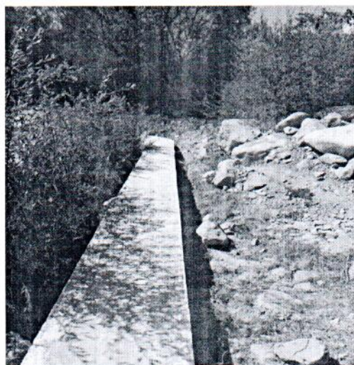
FOTOGRAFÍA N° 4 TRAMO 5, SE APRECIA LA FALTA DE RELLENO Y COMPACTADO CON AFIRMADO
